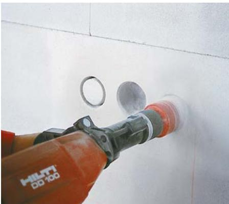
**Bild 5** Fräsen von Öffnungen für Schalterdosen
