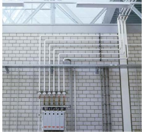
**Bild 11** Innensichtmauerwerk aus Kalksandstein mit befestigten Installationsleitungen
