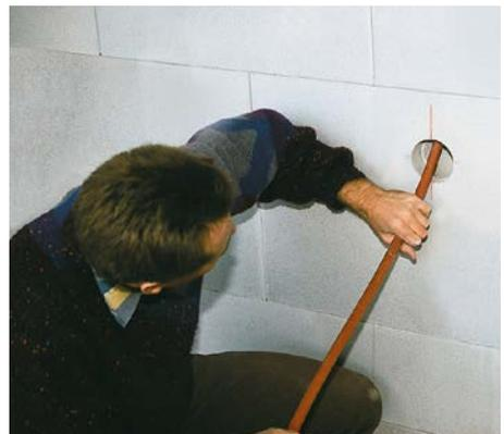
**Bild 6** Einziehen eines Leerrohres
