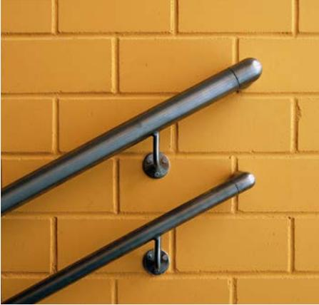
**Bild 10** Befestigung von Treppengeländern an KS-Mauerwerk
