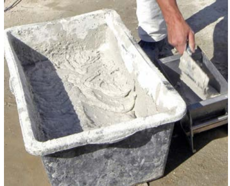
Bild 5 Der Dünnbettmörtel wird in den Mörtelschlitten eingefüllt.
