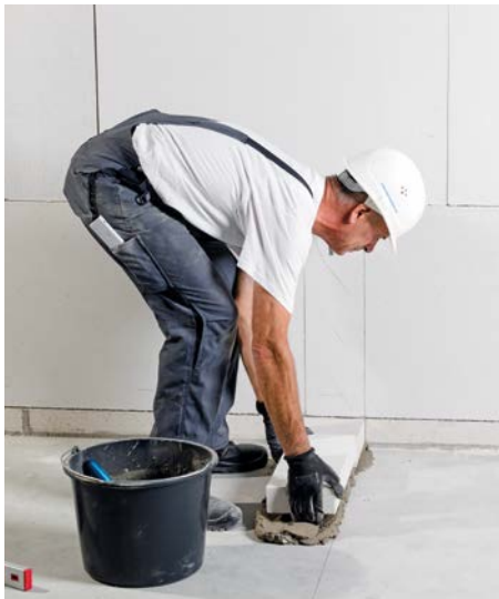
Bild 8 Kimmsteine ins Mörtelbett verlegen
