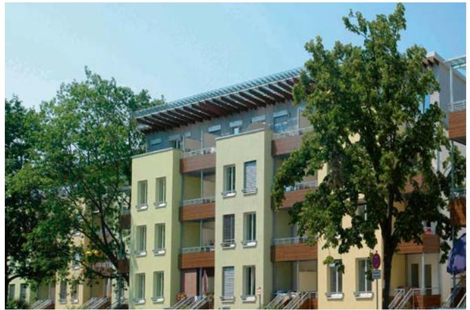
Mehrfamilienhaus (Sanierung 2009) – Passivhaus Aufstockung, 90439 Nürnberg, Außenwand: Kalksandstein mit WDVS,
