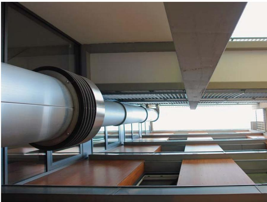
Frischluf- und Fortluftleitung der Lüftungsanlage
