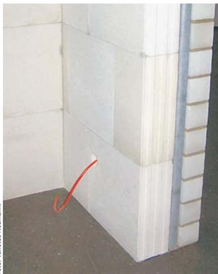
Modell einer zweischaligen Außenwand mit VIP-Dämmung
