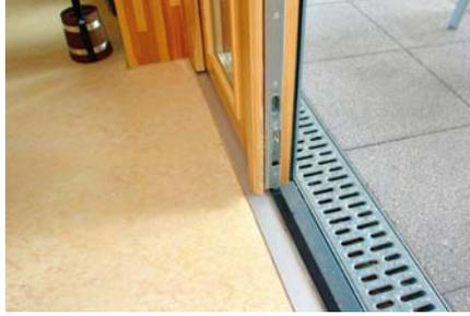
Einbau eines Fensters: barrierearme Schwelle
