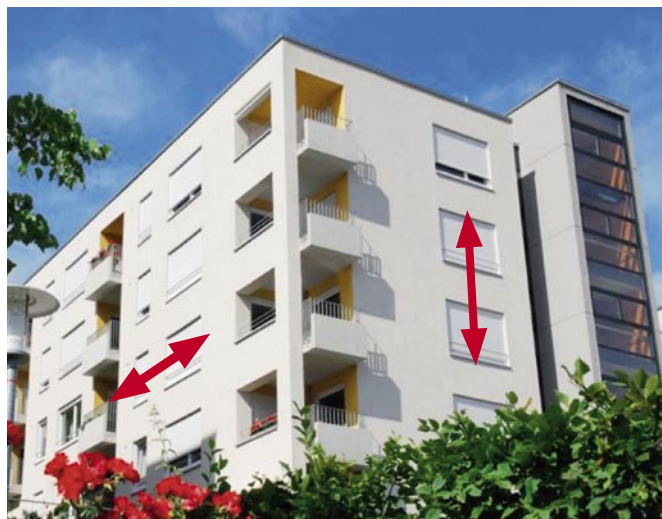
Bild 12: Horizontale und vertikale Schallübertragung
